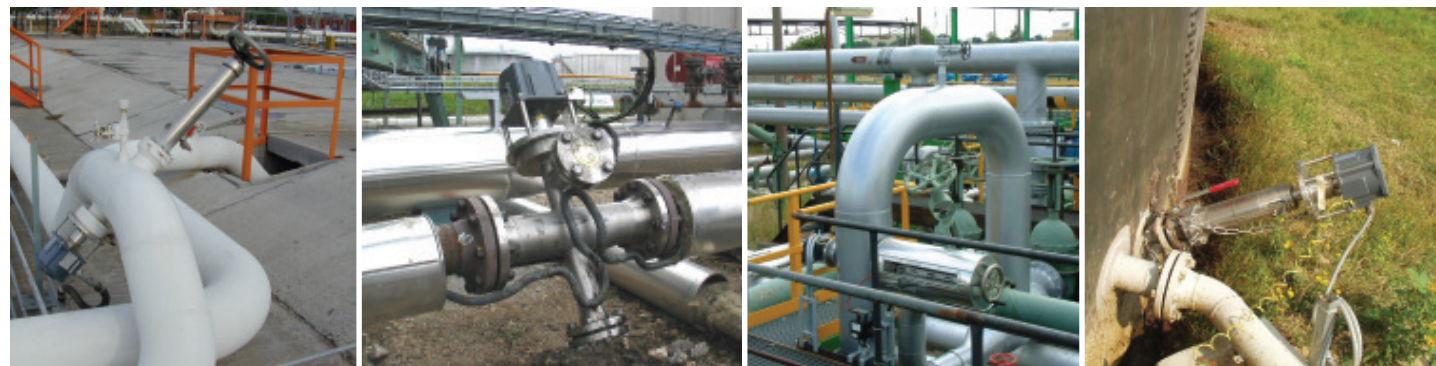
Pipelineeinbau mit Wechselarmatur
